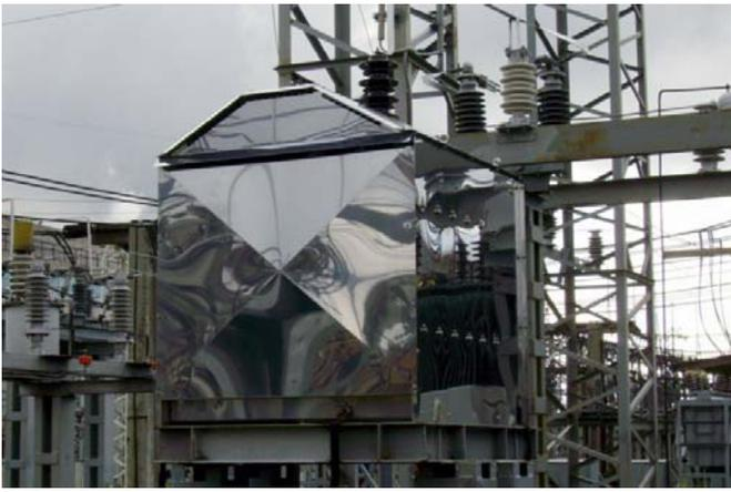
Рис. 3. Высокоомный резистор NER 35 кВ, 4000 Ом, 5 А (длительно) в сети ТЭЦ-11 Иркутскэнерго
